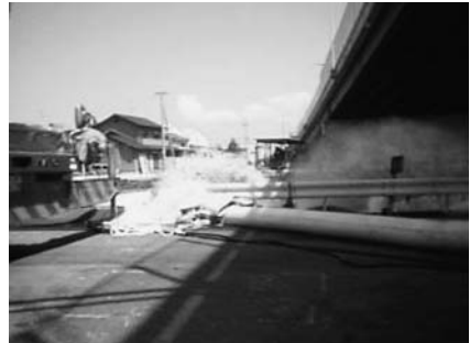
香西町の橋の下で水をくみ上げています
